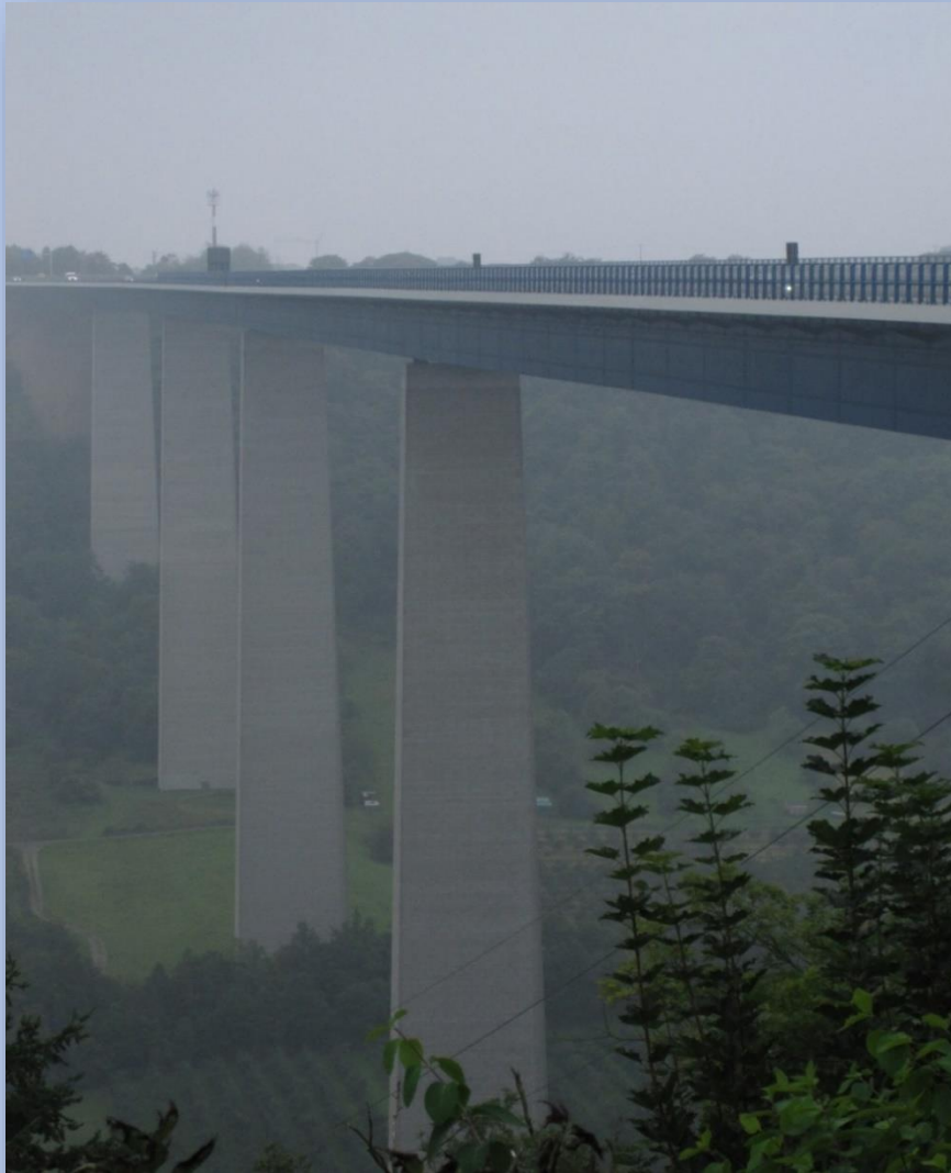
Moselbrücke bei Koblenz, Foto: H. Sickinger
